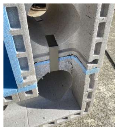
Enfoncer en force la pièce métallique de maintien des angles. Il y a une pièce sur le dessus et une pièce à mettre sur le dessous
