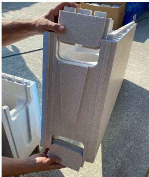
Mise en place des bouchons d'extrémité
