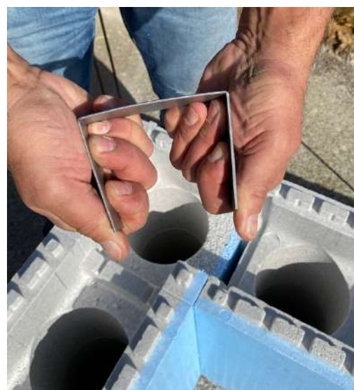
Cintrer légèrement les renforts d'angle métallique
