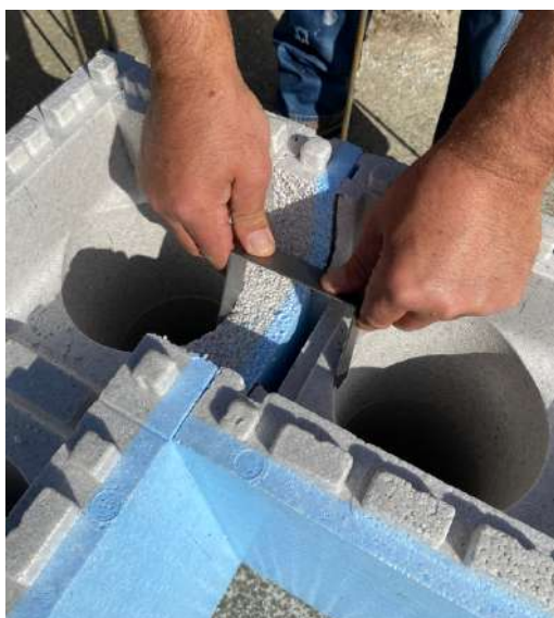
Enfoncer en force la pièce métallique de maintien des angles. Il y a une pièce sur le dessus et une pièce à mettre sur le dessous
