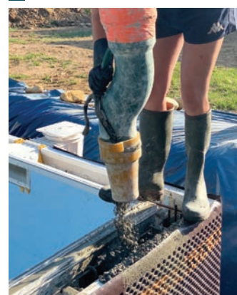
11 Coulage du béton
