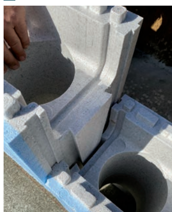
8 Assemblage du tenon-mortaise
