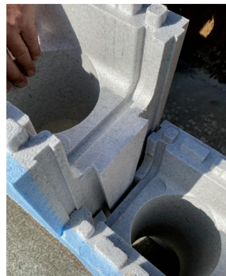
8 Assemblage du tenon-mortaise
